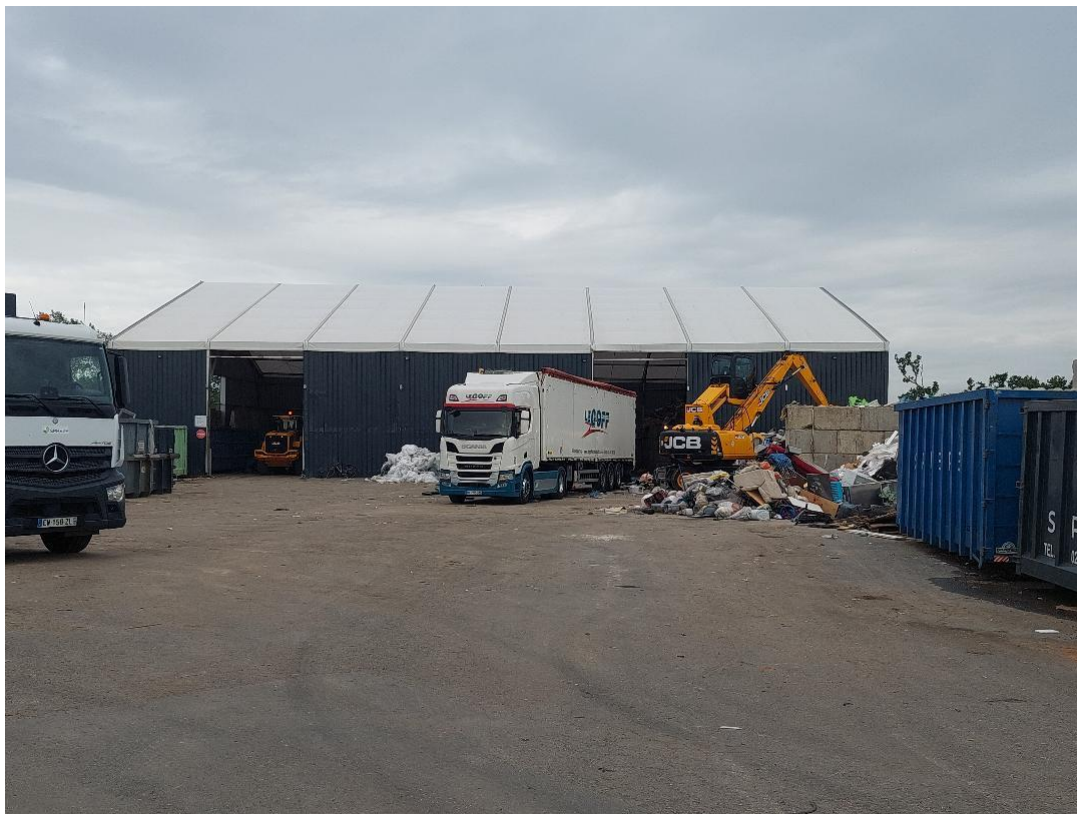
Vue générale du site avec : hangar de stockage des déchets « volants » ou risquant d'être rendus non récupérables par l'exposition à la pluie.
